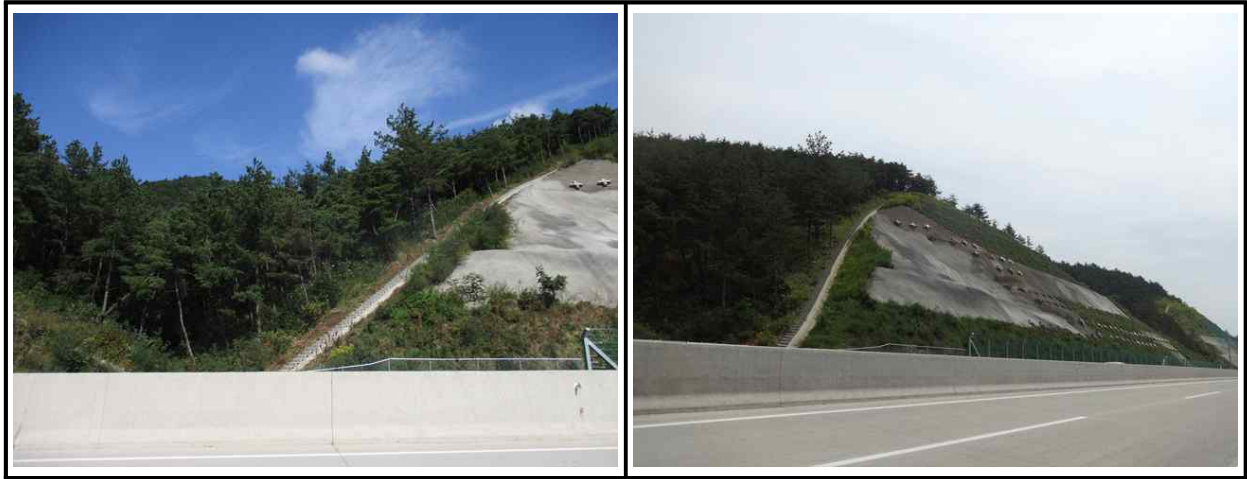
【그림 42.3.1】 상부자연사면 전경
