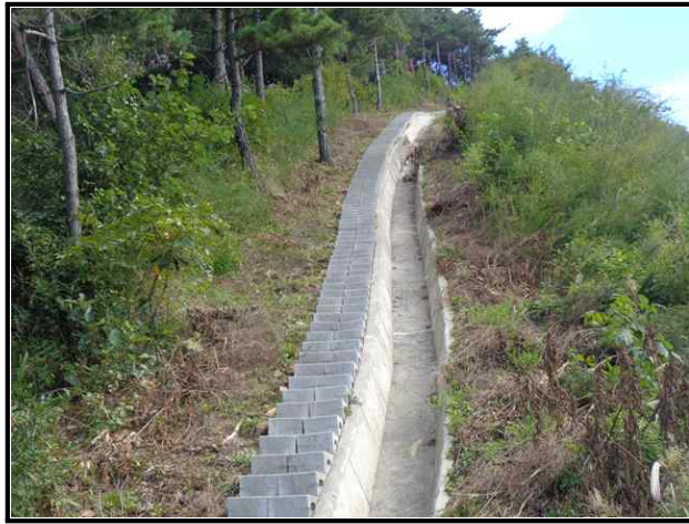
【그림 42.3.3】 배수시설 전경
